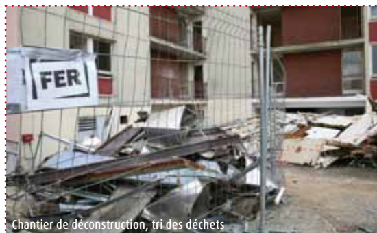
Chantier de déconstruction, tri des déchets
